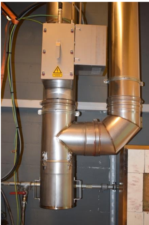
Vertikaler Einbau des OekoTube-Inside mit Staubsammelbox
