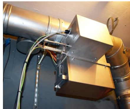
Horizontaler Einbau des OekoTube- Inside mit Staubsammelbox
