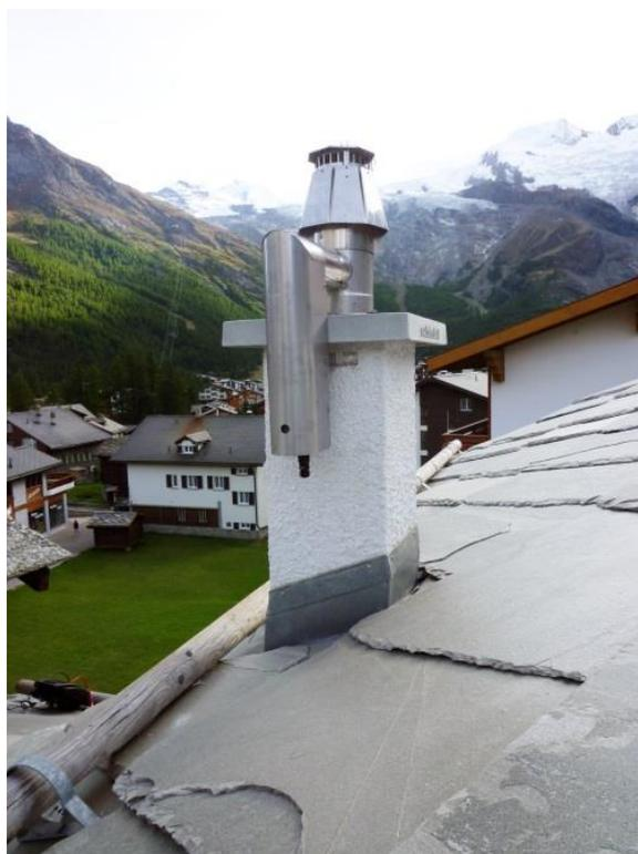
*Gemauerter Kamin mit überhängender Abschlussplatte*
