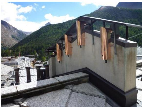
*Gemauerter Sammelkamin mit 5 Abgasrohren (Kupfer)*
