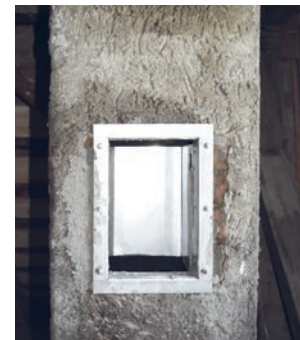
2. Einputzrahmen einmauern
