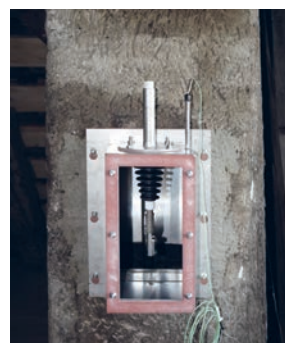
3. Abscheider an Einputzrahmen befestigen
