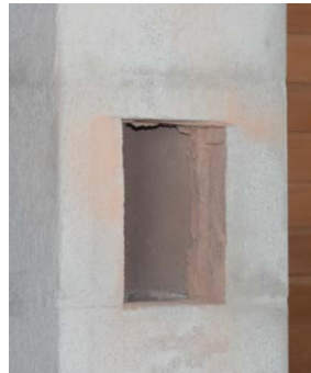
1. Öffnung in bestehenden Schornstein stemmen
