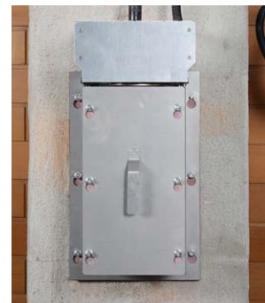
4. Serviceöffnung schliessen und elektrische Verbindung zur Steuerung herstellen
