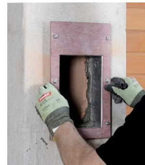
2. Einbaurahmen einmauern
