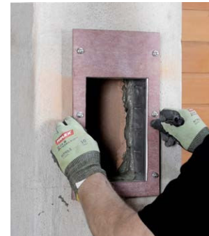
2. Einbaurahmen einmauern
