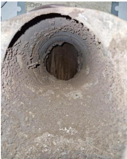
Verbindungsleitung nach dem Abscheider
